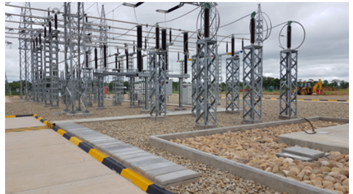
Sitio de construcción de la Bahía de Transformador 115 kV - Subestación Paraíso
