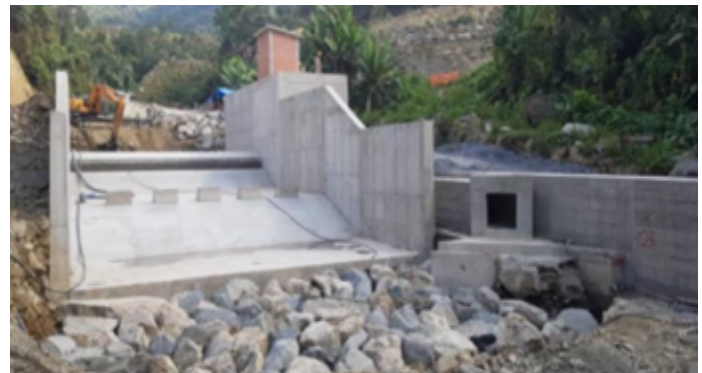
Obras civiles del proyecto
